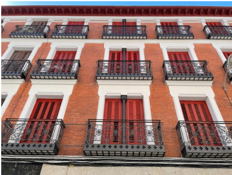
Edificio Los Madrazo 6, 8 y 10
