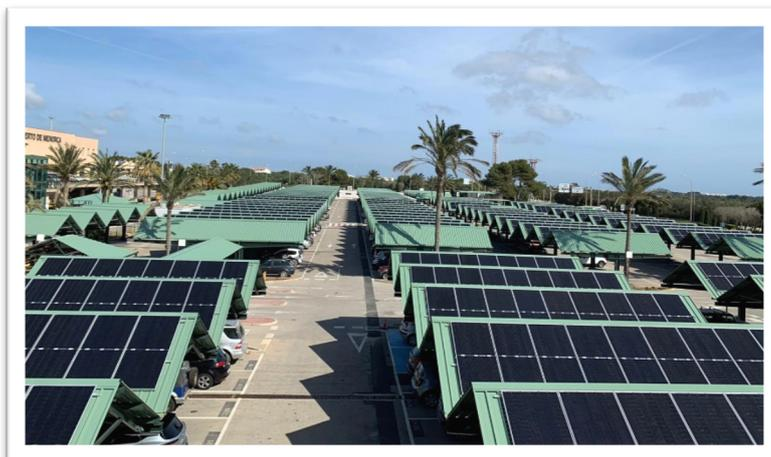
**FRINAVARRA, FRIGORÍFICOS DE NAVARRA.** Instalación de 1.125,96 kWp (3.412 paneles solares implantados). Con dicha instalación la cobertura del autoconsumo respecto del consumo total de la industria es del 14,7%.
