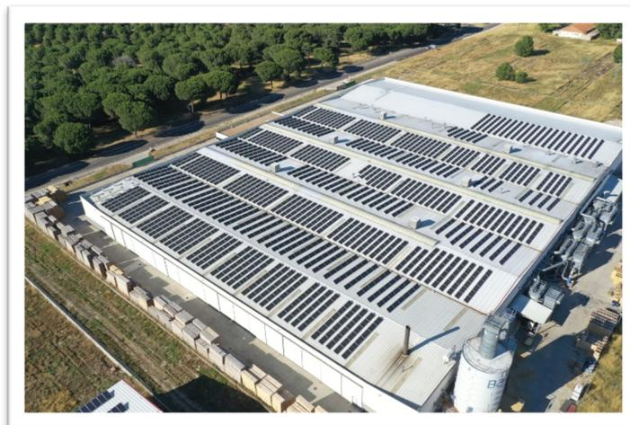
**MERCAVENTAS (Málaga).** Instalación de 626,7 kWp instalados sobre cubierta y suelo (1.794 paneles solares implantados). Con dicha instalación la cobertura del autoconsumo respecto del consumo total es del 36,2%.
