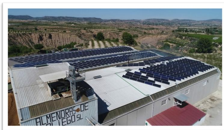
**AGROPOR-FINCA MOLINETA (MURCIA).** Instalación de autoconsumo sobre suelo con ampliación (total potencia instalada: 842 kWp Paneles solares instalados: 2.138). Con dicha instalación la cobertura del autoconsumo respecto del consumo total de la industria es del 24%.
