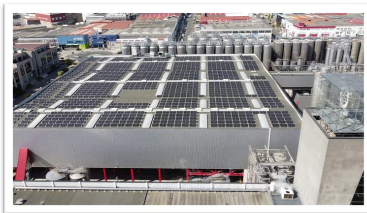
**PUERTAS BAMAR (Valladolid):** Instalación de 778,3 kWp (1.810 paneles solares implantados). Con dicha instalación la cobertura del autoconsumo respecto del consumo total de la industria es del 50,3%.
