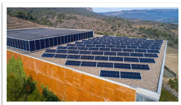
**ALMENDRAS PLIEGO (MURCIA).** Instalación de autoconsumo aislada, sin conexión a red, de 176 kWp (549 paneles solares) y 198 baterías. Es una de las instalaciones aisladas más grandes a nivel nacional. En este caso la cobertura mediante autoconsumo es del 100%
